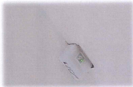
Usytuowanie oprawy na drodze ewakuacyjnej
